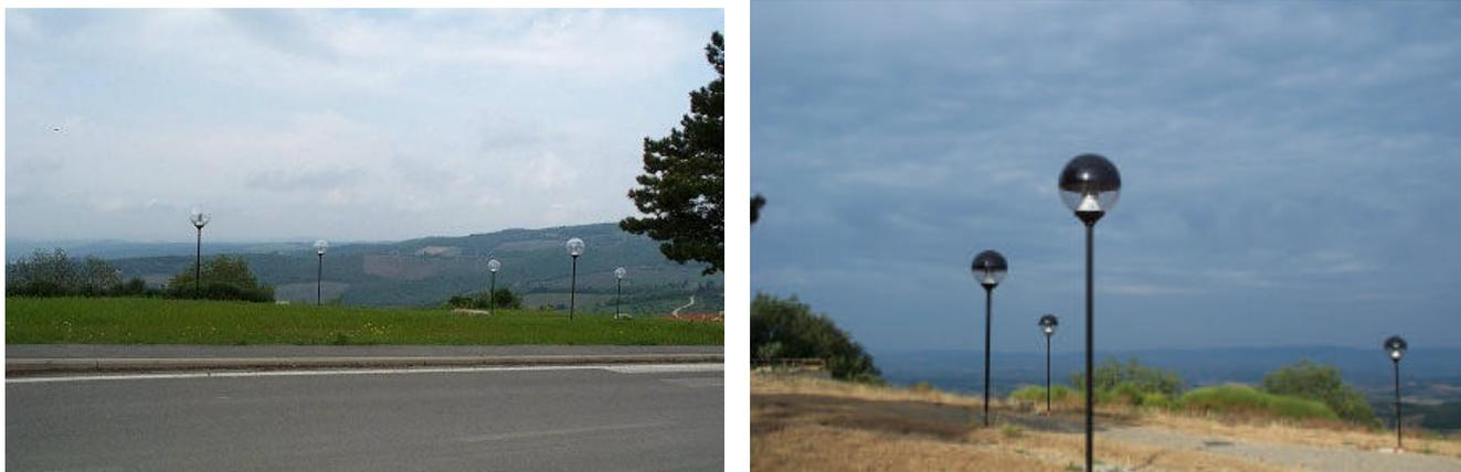
*Figura 28 - Impianto con diffusori a sfere prima e dopo l'intervento di adeguamento. E' comunque vietato utilizzare questo tipo di corpi illuminanti per la realizzazione di un nuovo impianto.*
